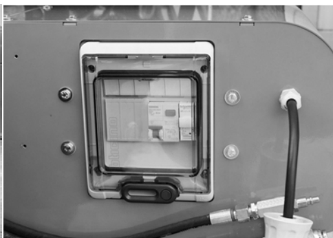
Fig. 90 Automatisk magnetotermisk afbryder
