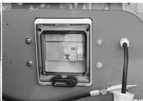
Fig. 161 Automatisk magnetotermisk afbryder
